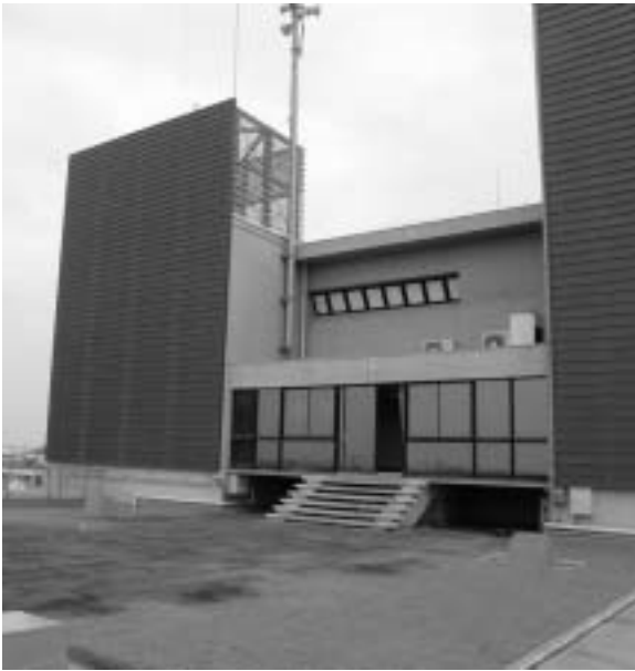
庁舎屋上の太陽光発電パネル
